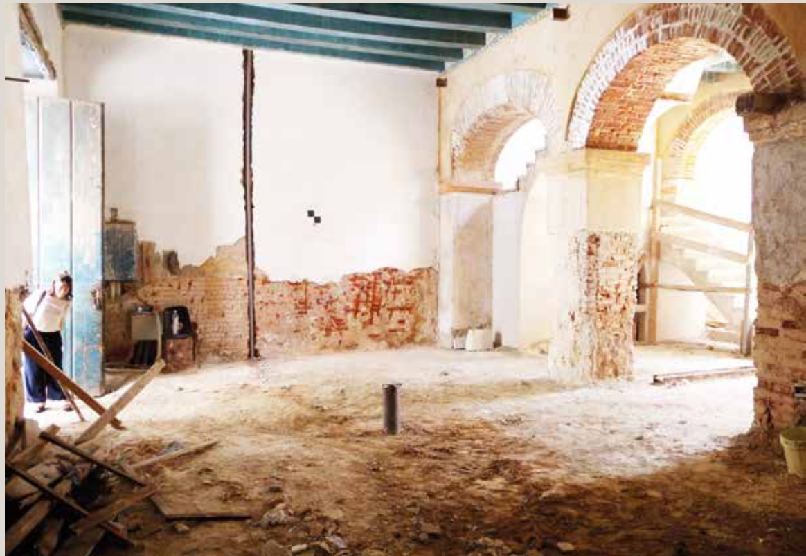
Espacio de acceso al centro REDI, planta baja. Estado Actual (arriba, foto D. Del Curto, 2017) y proyecto de mobiliario con escalinata, rampa y mostrador de bienvenida (diseño de D. Del Curto y G. Menini 2017)
